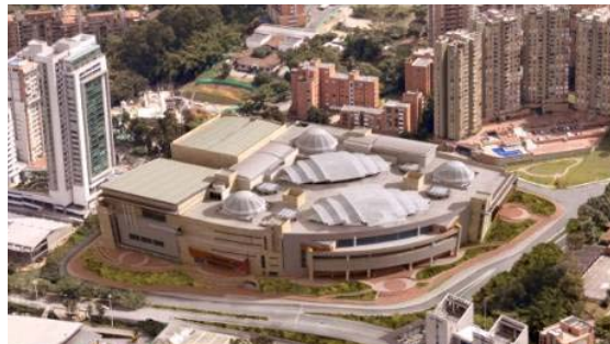
Centro Comercial Santafe-Medellin-Colombia Architect: Victor Rincon Promotor: Pedro Gomez YCIA Constructor: Inverciones Bocacolina Sky-light sub constructor: Arcos Sistemas Arquitectonicos
